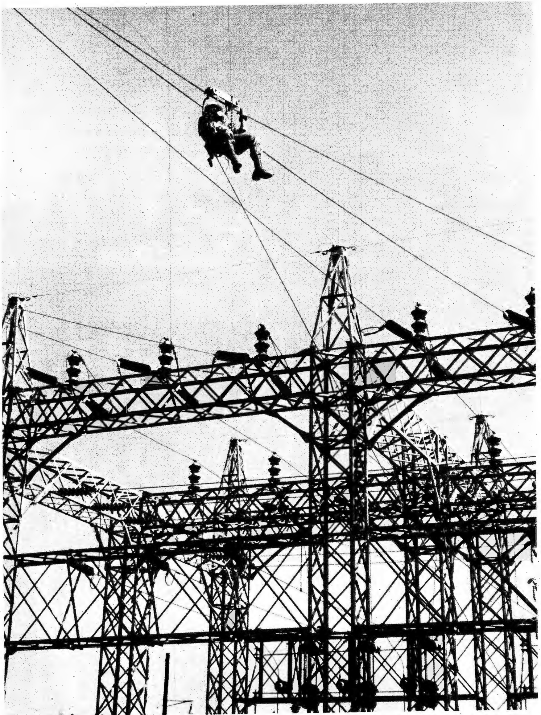
SOBRE LA SUB-ESTACION DE SAN AGUSTIN UN TRABAJADOR REVISA DESDE UN CARRIL —FUNICULAR INDIVIDUAL— EL ULTIMO TRAMO DE LA LINEA MARIEL-HABANA
