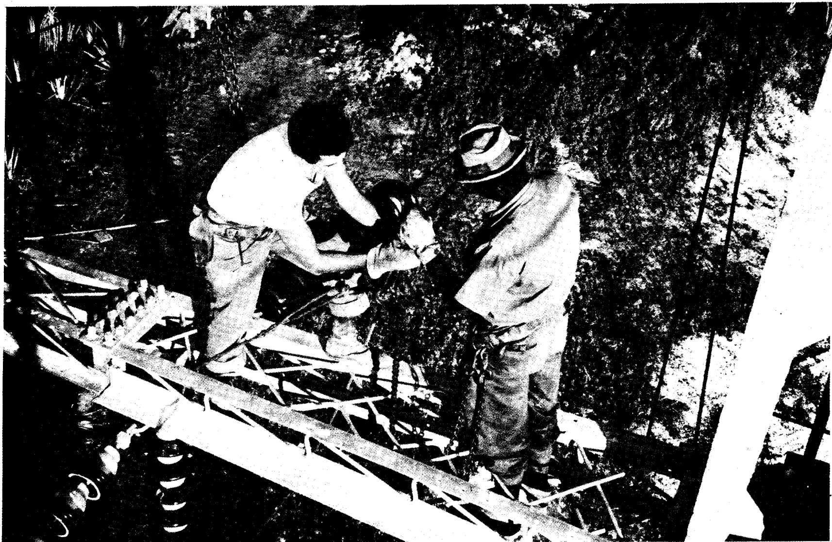
CON LA AYUDA DE UN DIFERENCIAL DE PALANCA SE NIVELA UNA CRUCETA. LOS TRABAJADORES, DEBIDO A LA ALTURA, TOMAN MEDIDAS DE SEGURIDAD
